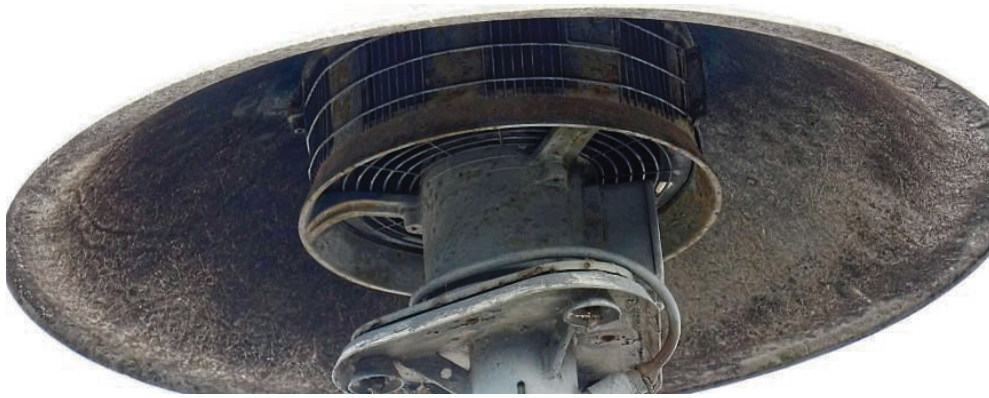
Mit ohrenbetäubendem Geheule warnen Sirenen wie die auf dem Dach des Rathauses Ober-Roden vor Gefahren. Nach dem Ende des Kalten Krieges wurden in Deutschland viele Anlagen abgebaut. In Rödermark blieben sieben übrig. FOTO: LÖW
